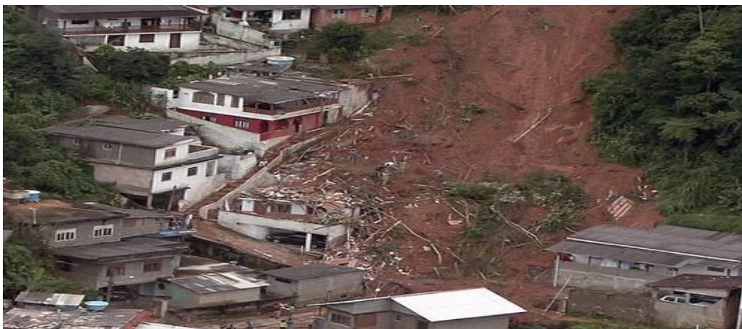
Figura 1. Destroços na cidade de Teresópolis-RJ (Fonte: O GLOBO, 2011).
